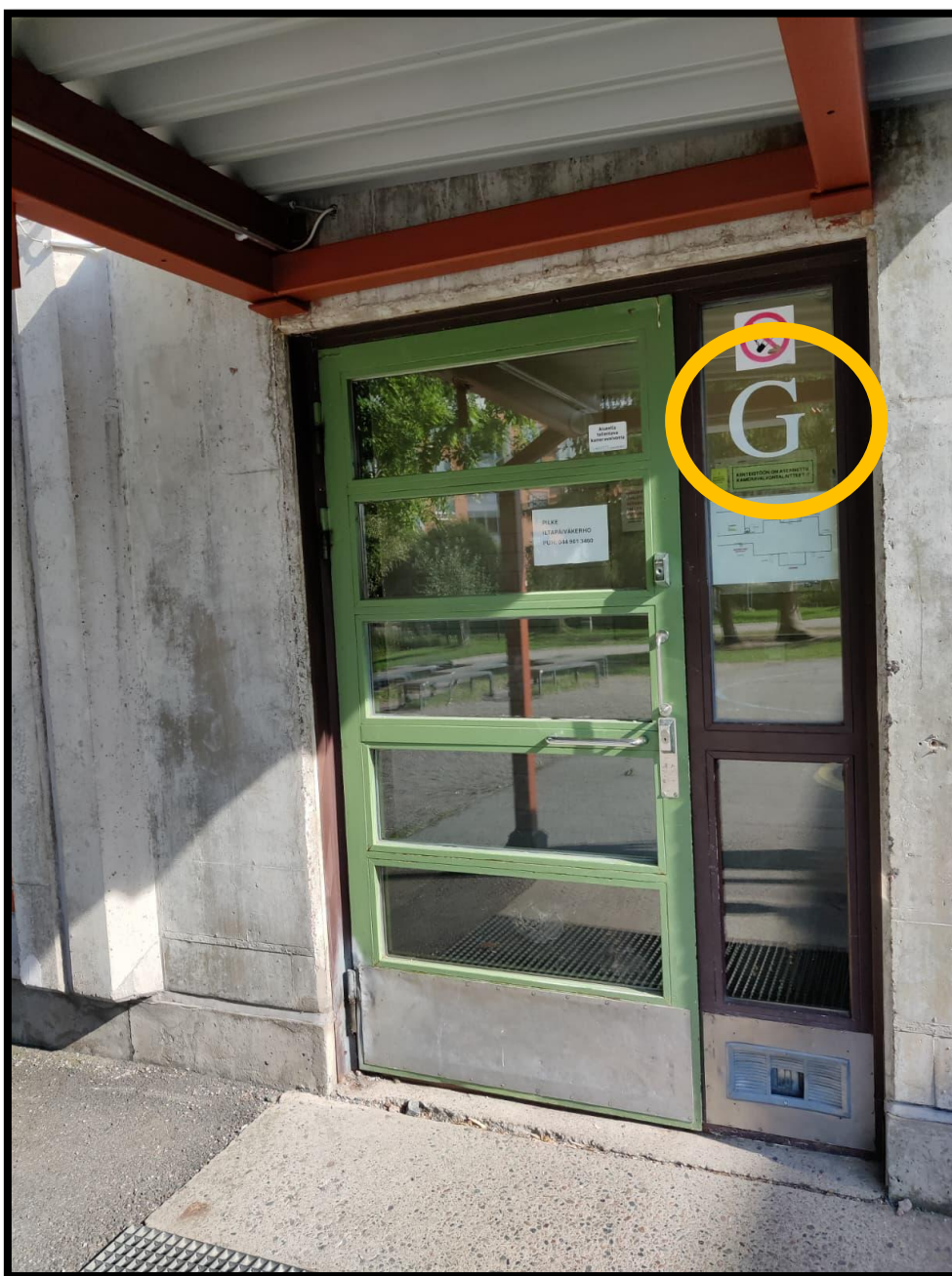
Kuva 3. Pähkinärinteen koulun liikuntasalin sisäänkäynti.
